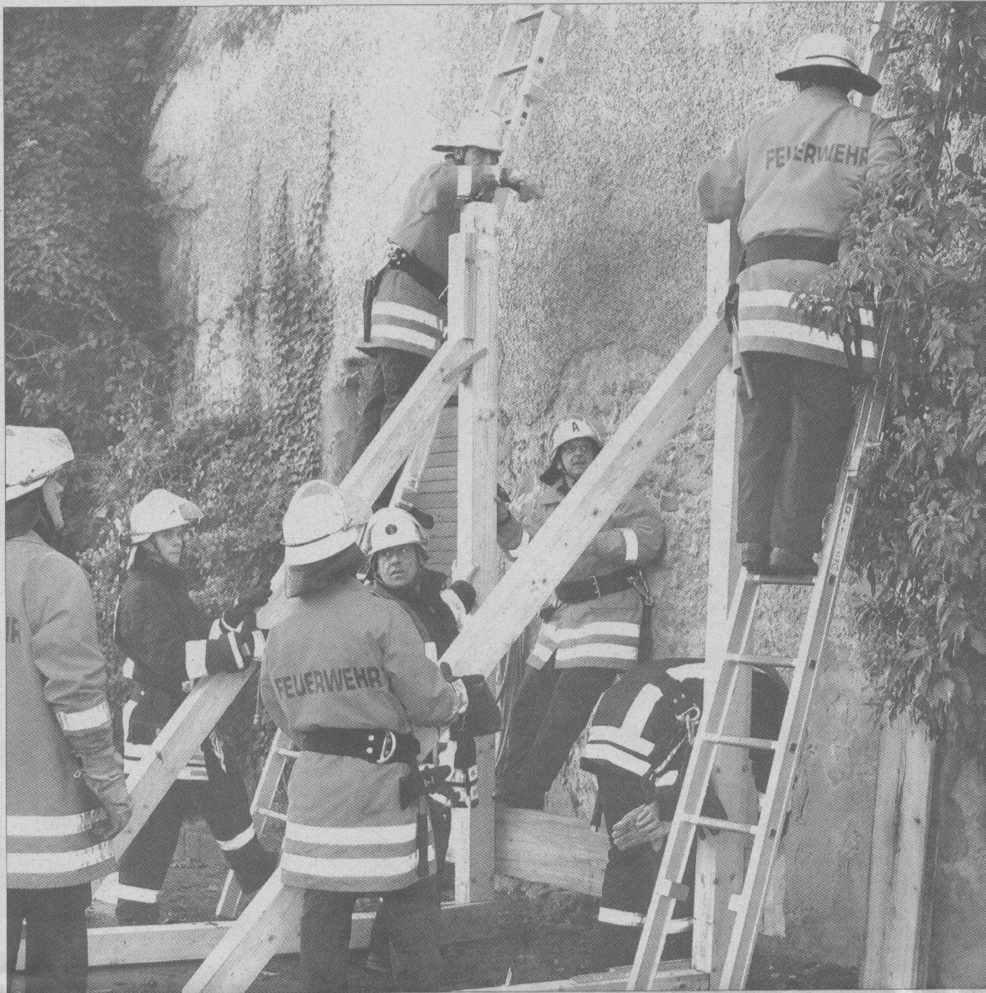
Beim Abstützen einer Wand mussten sich die Brandbekämpfer auch als Zimmerer betätigen.
